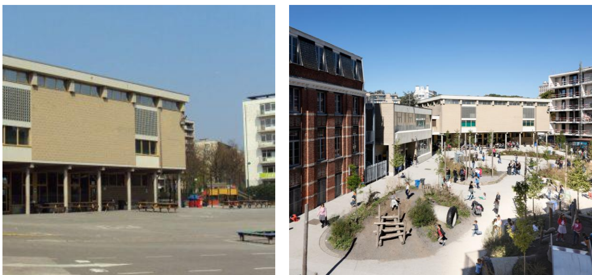
Figure 2 : Photographies avant et après le chantier de la cour
